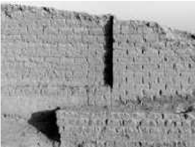
Fig. 63 - TB1, facciata meridionale dell'edificio sul sommo della collina, dettaglio da sud.
