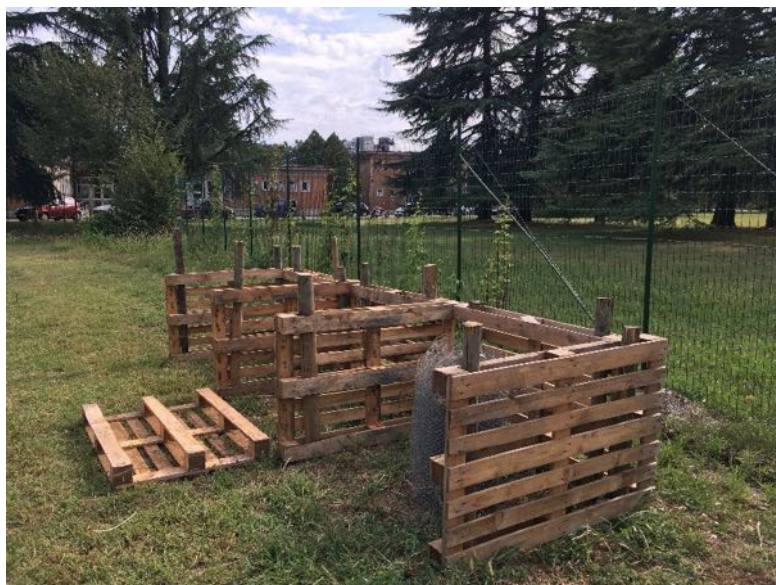
Figura 3 – La costruzione del compostatore con bancali di recupero
