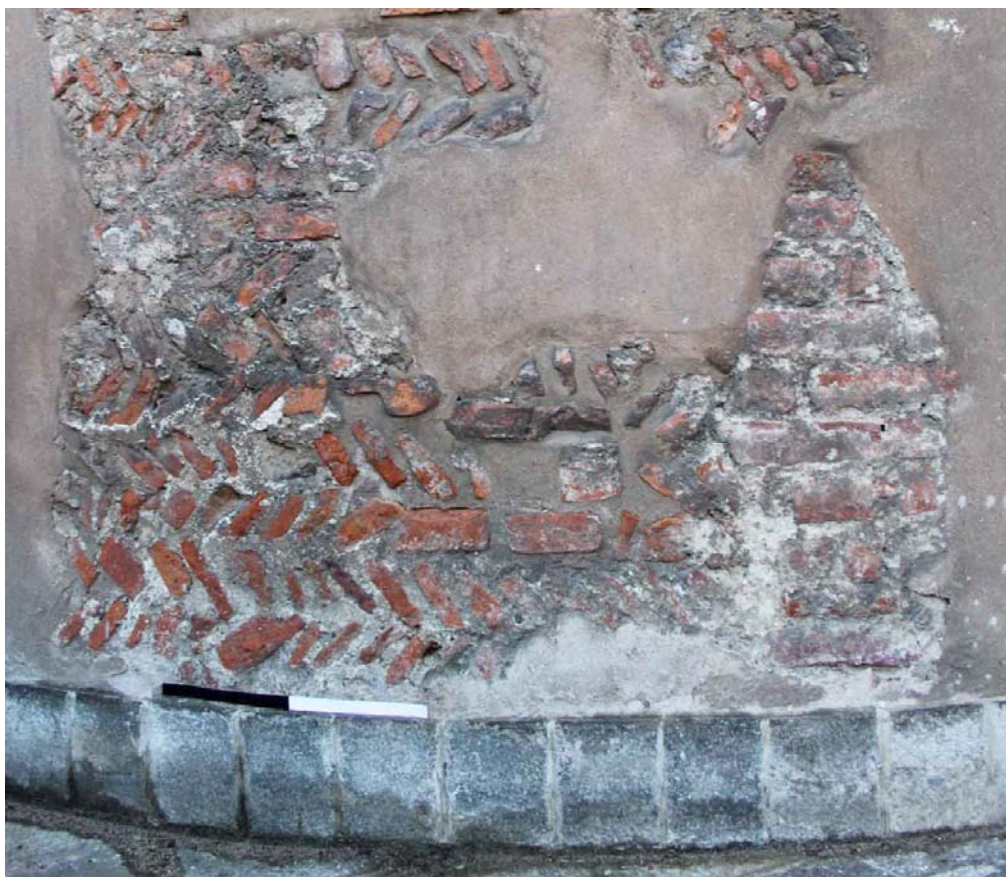
Fig. 7. Tecnica costruttiva del sacello di San Vittore in Ciel d'Oro (metà V- VI sec. d.C.).
