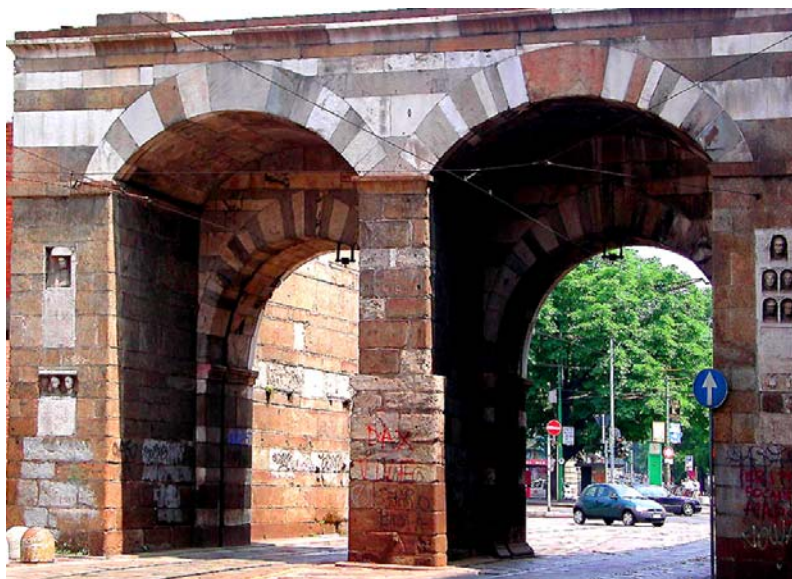
Fig. 5. Concio di Trachite euganea riutilizzato come chiave di volta, fornice destra, Archi di Porta Nuova, fronte su via Manzoni.
