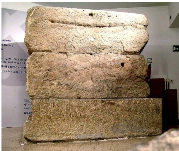
Fig. 3. Pilastro del Teatro costituito da grandi conci di Ceppo (sotterraneo di un edificio di via San Vittore al Teatro).
