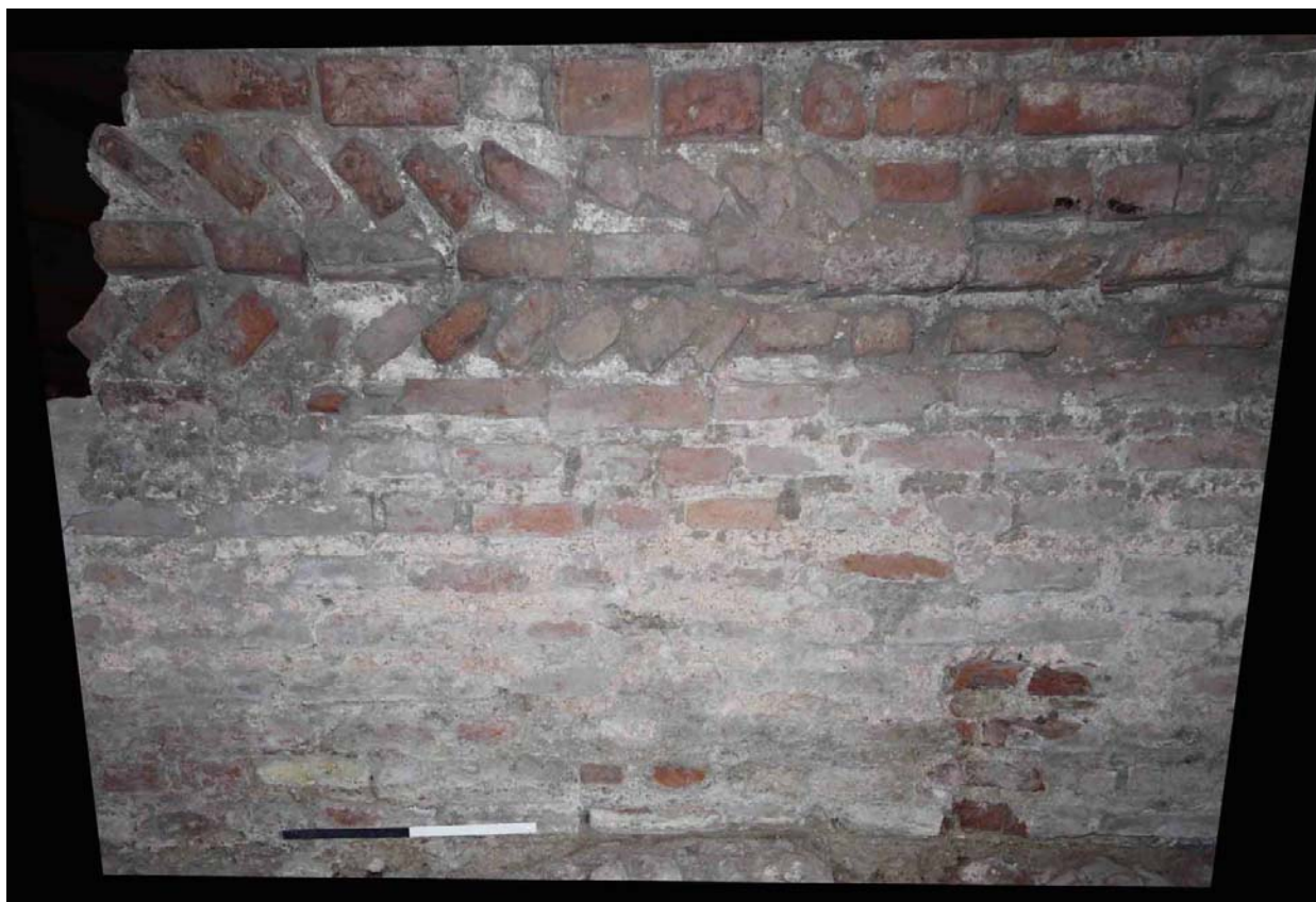
Fig. 6. Tecnica costruttiva dei paramenti esterni del battistero di San Giovanni alle Fonti (fine IV sec. d.C.) (fotoraddrizzamento).
