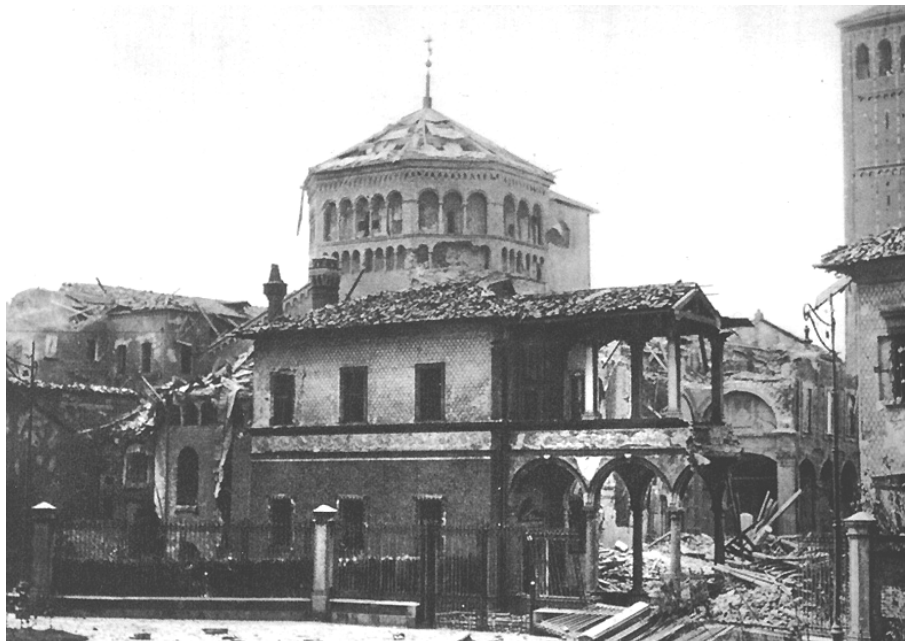
Fig. 1. Danneggiamenti dei bombardamenti della basilica di Sant'Ambrogio nel 1943 (www.wikipedia.org).
