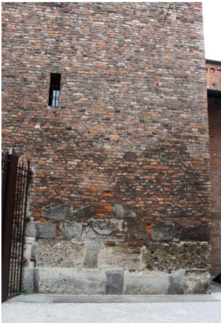
Fig. 8. Basamento del campanile dei Monaci in Sant'Ambrogio.
