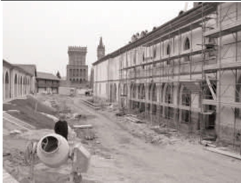
Dall'alto l'Agenzia prima dei lavori di recupero e durante i lavori di ristrutturazione
