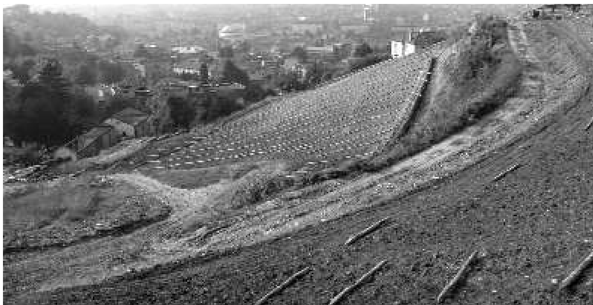
I lavori d'impianto del vigneto e nella pagina a fianco il risultato dell'intervento
