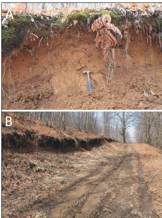
Fig. 25. Affioramento di colluvium di suolo (sabbie siltoso-argillose debolmente ghiaiose) sulle morene di Magnano (A). Posizione degli affioramenti per sbancamento stradale sul fianco esterno della morena; si noti la gran quantità di fango argilloso sulla carrareccia (B).
