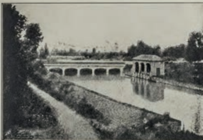
Il Canale Cavour con un grandioso sifone passa sotto il torrente Ebro.
