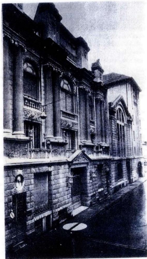
Figura 12 Facciata edificio “Unione e Benevolenza”
