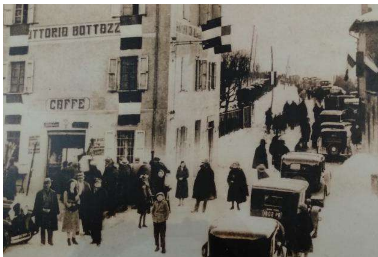
Figura 18 Primi anni del Novecento: la fila degli sciatori in fila sulle autovetture nella principale via del paese.
