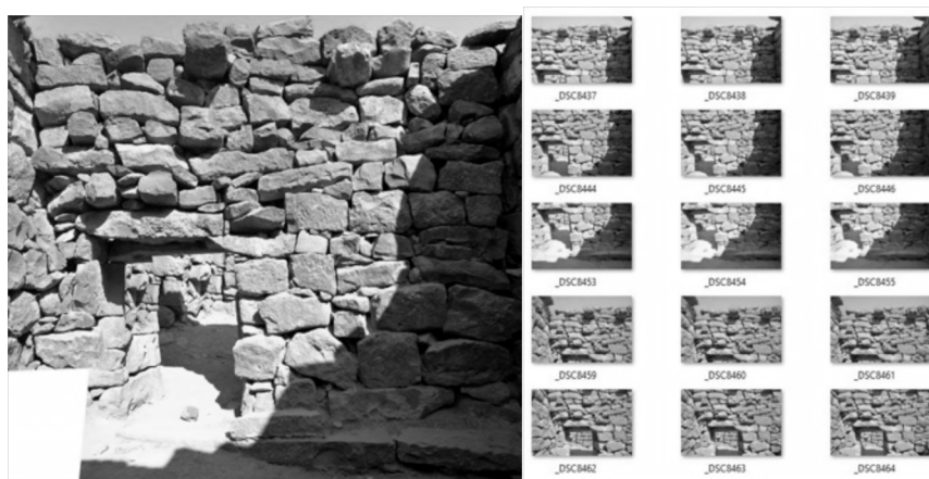
Fig.5: prospetto murario dell'UT24 rilevato con 15 foto
