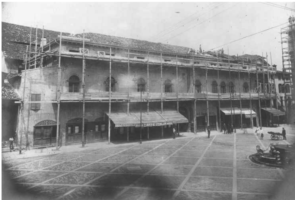
1. Ponteggi sulla facciata di Palazzo del Podestà negli anni Venti del Novecento.
