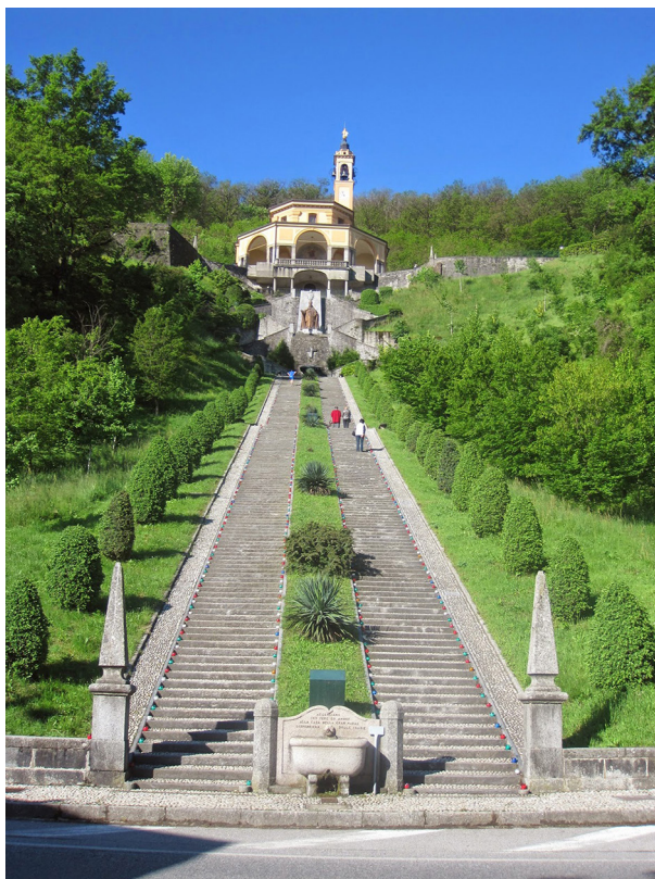
Fig. 1 - Santuario della Madonna del Bosco di Imbersago, con la Scala Santa e il monumento a Papa Giovanni XXIII
