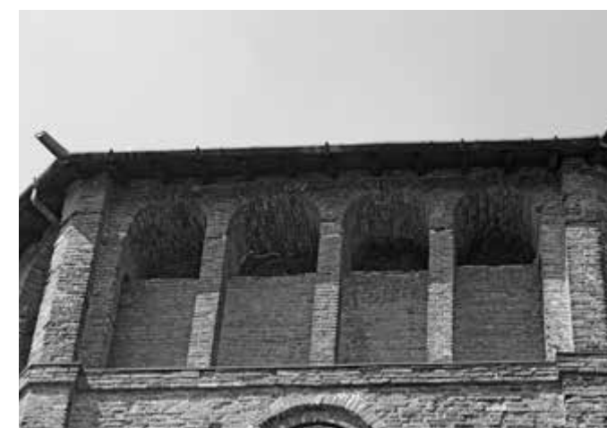
19. Muro di fondo del loggiato con brani murari a mezza spina pesce
