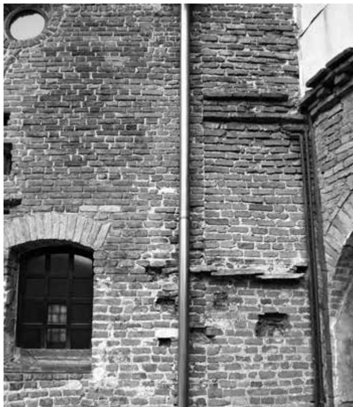
12. Soluzione costruttiva di raccordo tra il tetraconco e l'atrio del mausoleo sul fronte orientale
