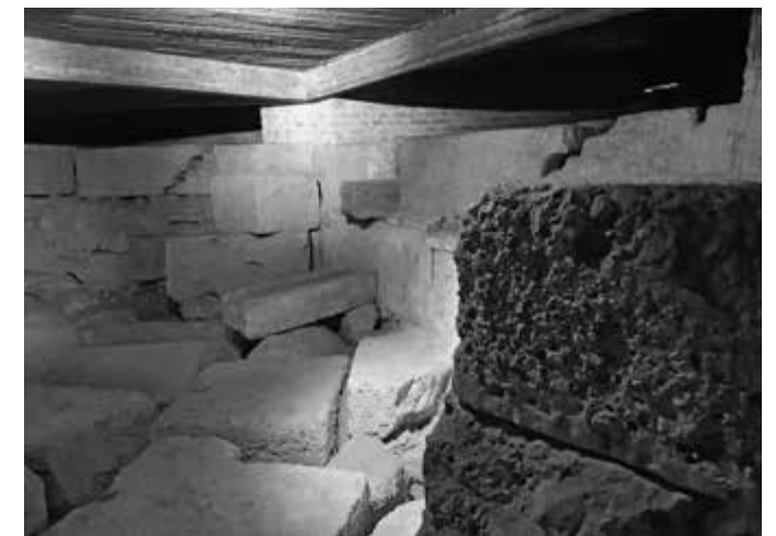
7. Canaletta passante nelle fondazioni, documentata nell'area ispezionabile delle fondazioni di Sant'Aquilino
