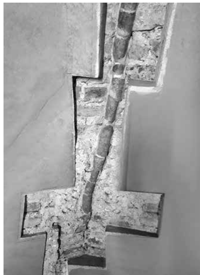
17. Tratto in tubi fittili all'intersezione di due vele della volta di Sant'Aquilino
