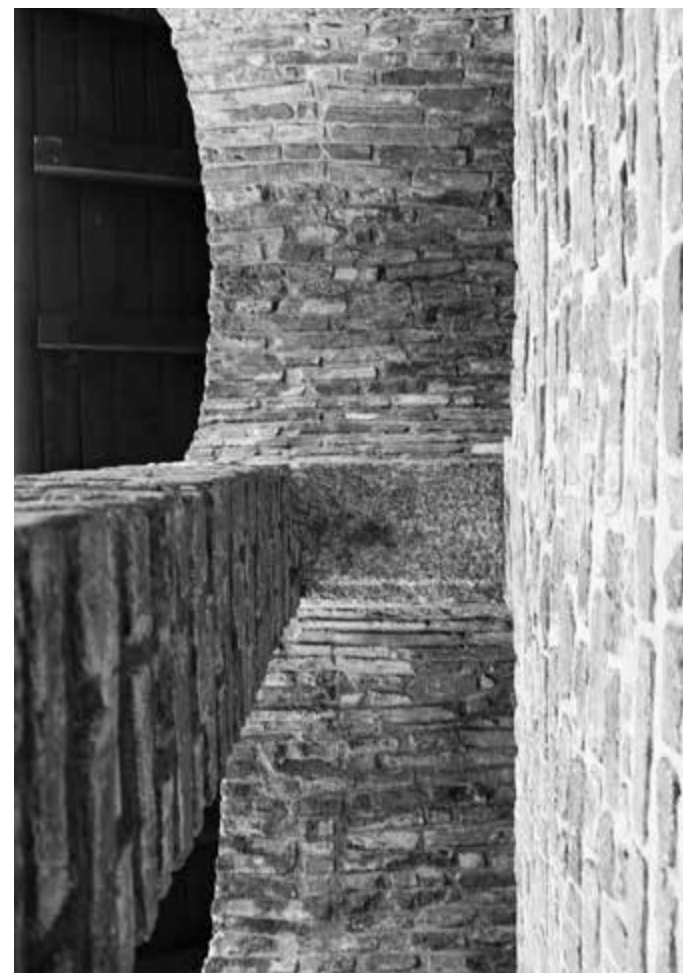
20. Impiego di laterizi con dimensioni differenziate e tegole nelle voltine del loggiato del mausoleo.
