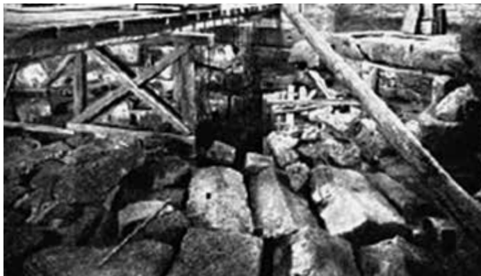
4a-b. Fotografie della platea di fondazione dell'ottagono di Sant'Aquilino messa in luce durante gli scavi del 1911
