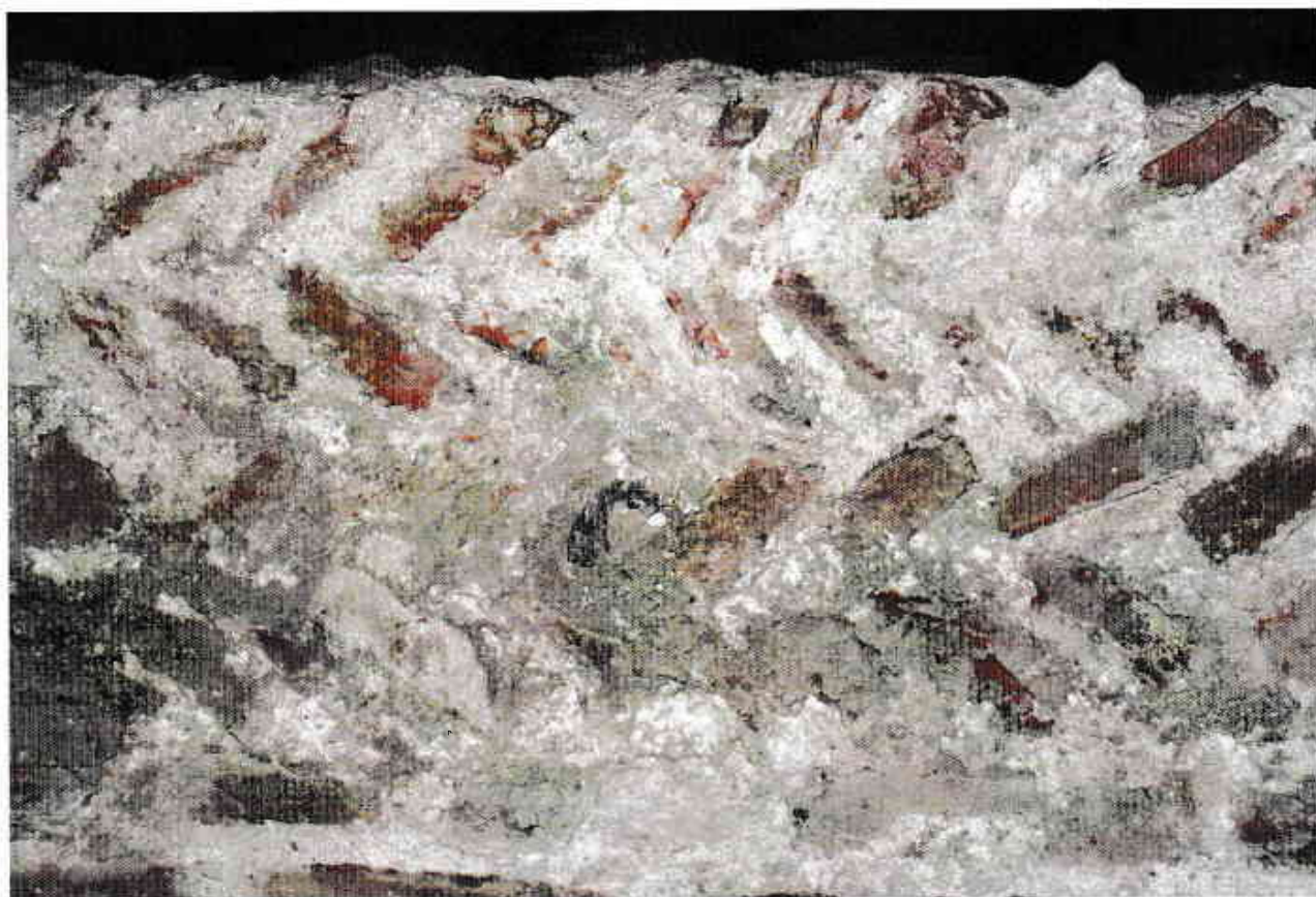
Particolare della tecnica costruttiva dell'abside paleocristiana (foto P. Greppi).
