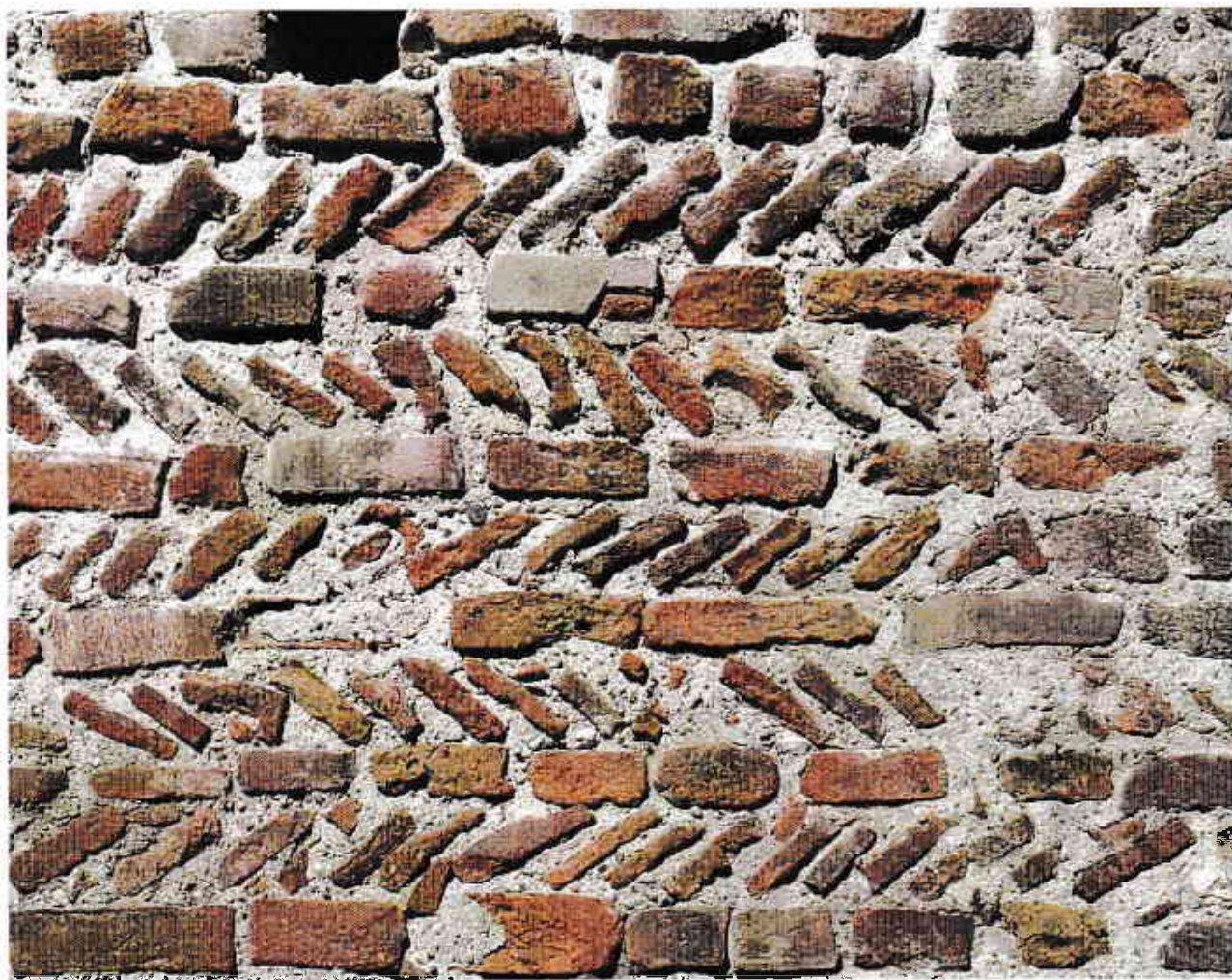
Particolare della tecnica costruttiva della base dell'abside romanica (foto raddrizzamento P. Creppi).
