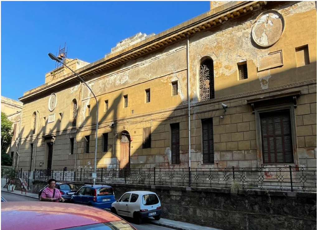
2: La Mantia, C., Foto del prospetto della Real casa dei matti allo stato attuale, agosto 2022.
