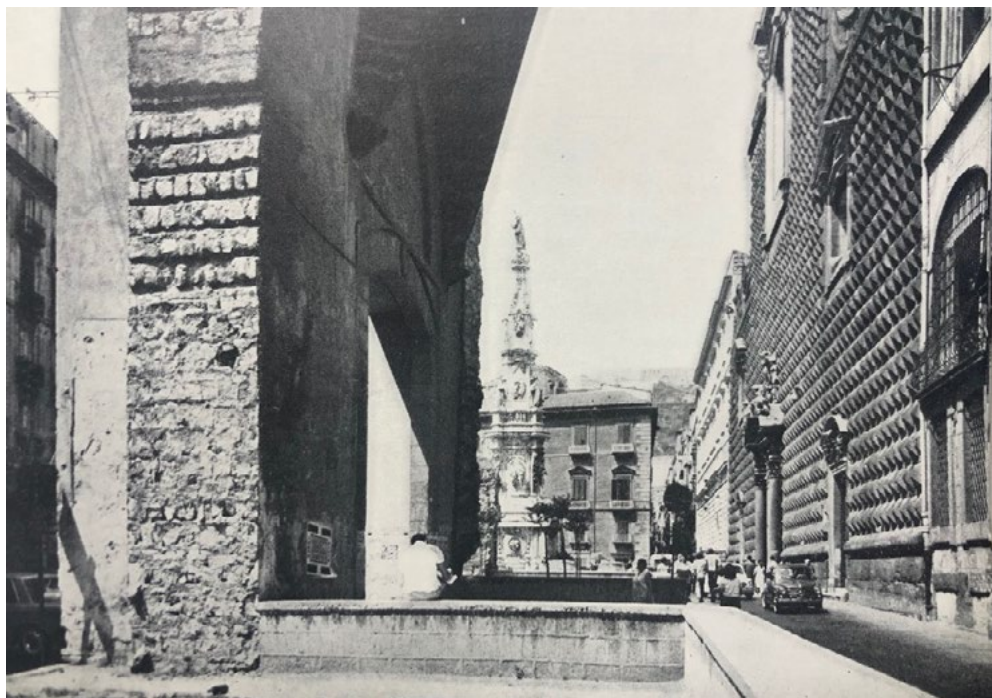
4: La situazione dell'ingresso al sagrato di Santa Chiara prima della sistemazione definitiva in una fotografia di Roberto Pane. Si noti la posizione del portale e della gronda ogivale arretrati di due metri rispetto al primitivo ciglio stradale [Pane R. et al. 1971].
