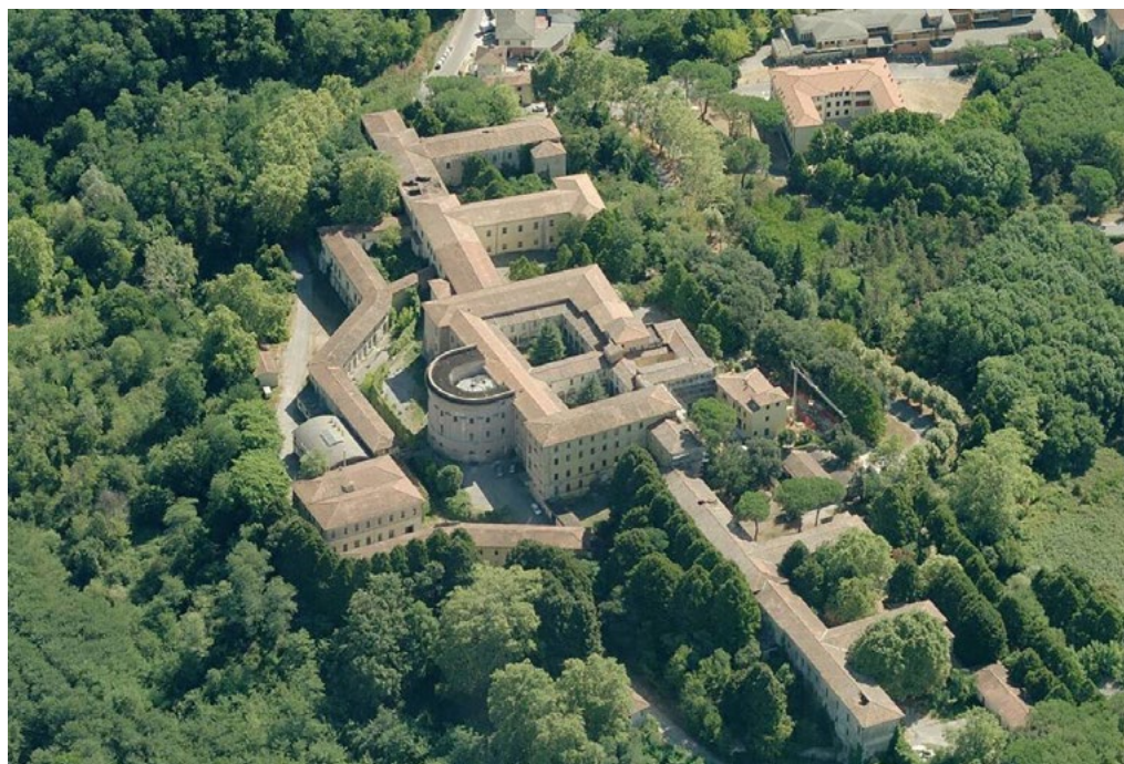
1: Veduta aerea del complesso di Fregionaia a Maggiano, Lucca.
