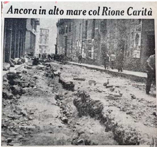
4: Napoli: via San Giacomo. Lavori di sistemazione della pavimentazione stradale, in «Tempo», 22 settembre 1958 (Archivio di Stato di Napoli).
