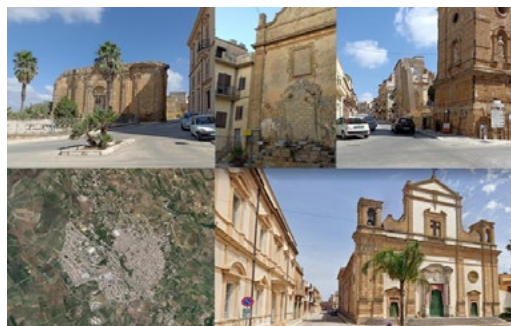
5: Partanna (TP). Immagini aeree e di dettaglio dell'abitato, al cui interno i resti monumentali dell'antico abitato sono stati reinseriti nella nuova struttura urbana, talvolta ricostruiti, talvolta lasciati allo stato di rudere.
