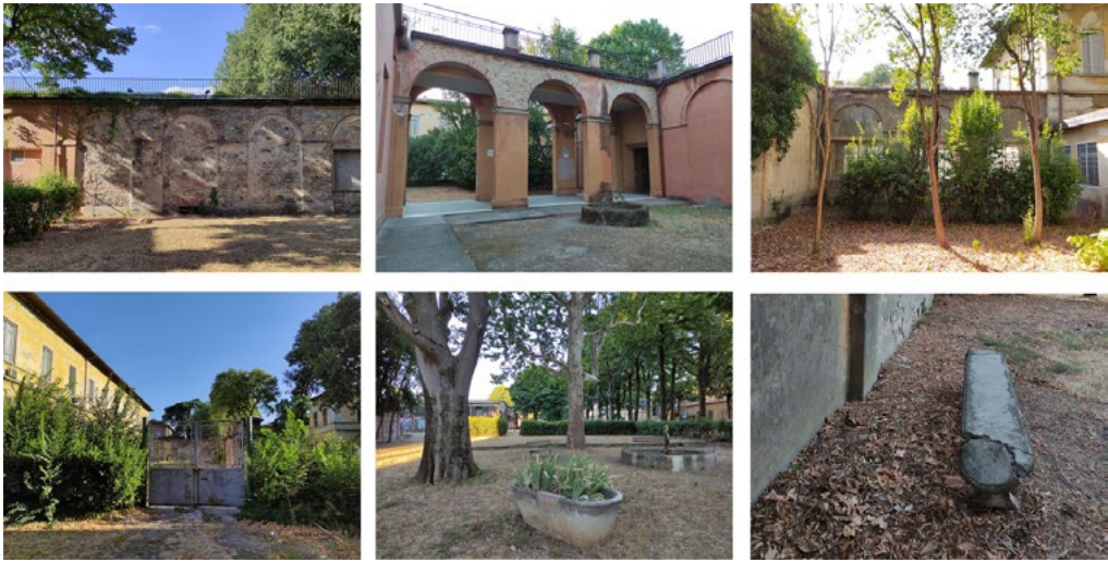
5: Analisi delle condizioni attuali delle gallerie e degli spazi verdi dell'ex Manicomio San Salvi di Firenze [Foto di S. Landi, 2022]
