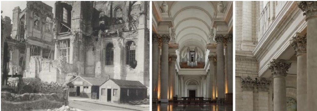
2: A sinistra: la navata della cattedrale dopo i bombardamenti; al centro e a destra, la stessa navata dopo i lavori di ricostruzione.
