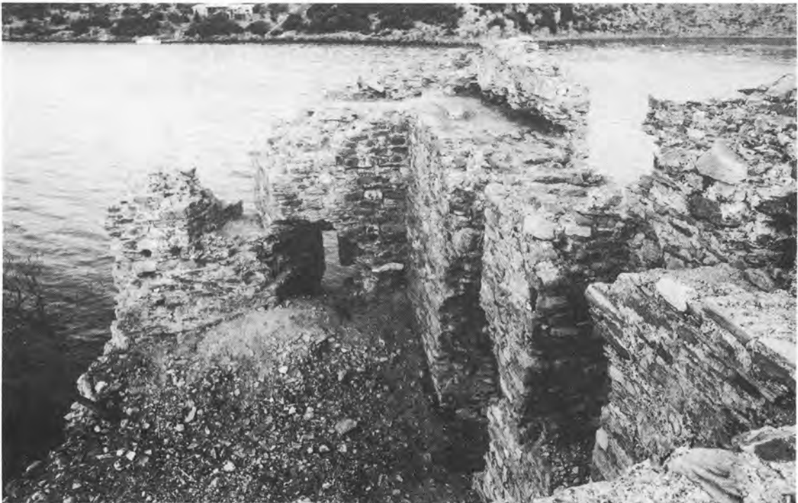
Fig. 4 - Iasos. L'interno della torre. Lati Ovest e Nord.
