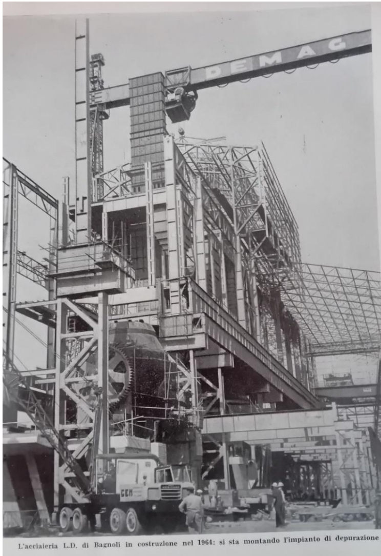
Figura 4. L'installazione delle caldaie di recupero sui convertitori della nuova acciaieria LD di Bagnoli, nel 1964. Si noti la dizione "impianto di depurazione", etichetta assegnata nel 1971 dai tecnici di stabilimento agli impianti di ottimizzazione in questione. Italsider SpA, "Bagnoli Notizie", Anno XI, n. 8-9, agosto-settembre 1971. IanCo 82cNa.
