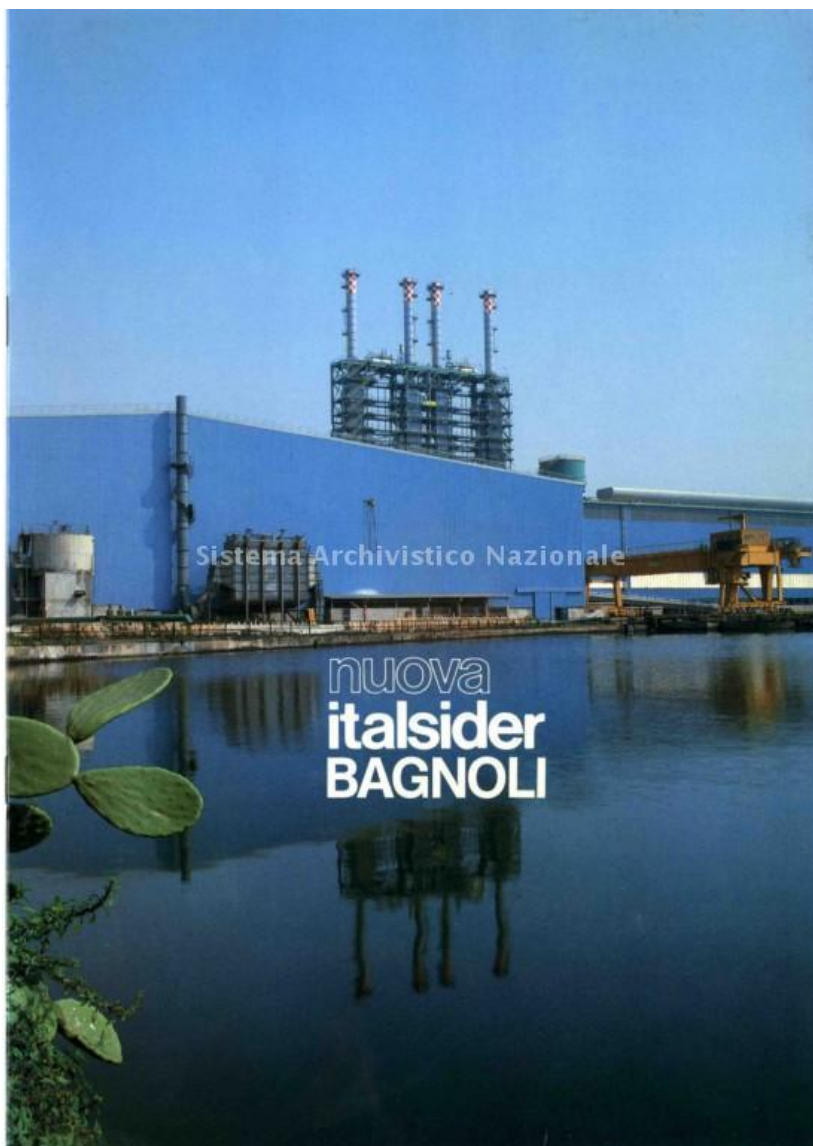
Figura 4. Il volto della Nuova Italsider di Bagnoli dal 1984, dopo la ristrutturazione. Fonte: Portale digitale SAN, Sistema Archivistico Nazionale
