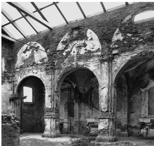
Fig. 3. Chiesa di Santa Maria del Salice, interno; prime tre campate del lato nord. Si distinguono i primitivi archi a sesto acuto che separavano la navata centrale dalle laterali, riportati a tutto sesto in concomitanza con l'incamiciatura dei pilastri, e l'impronta delle volte nella parte sommitale (foto Silvio Pagliero).
