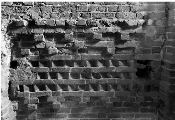
Fig. 4. Chiesa di Santa Maria del Salice, interno del campanile, primo livello; fregio in cotto a denti di sega ed elementi scalari sulla porzione sommitale della parete nord, un tempo all'esterno (foto Viviana Moretti).
