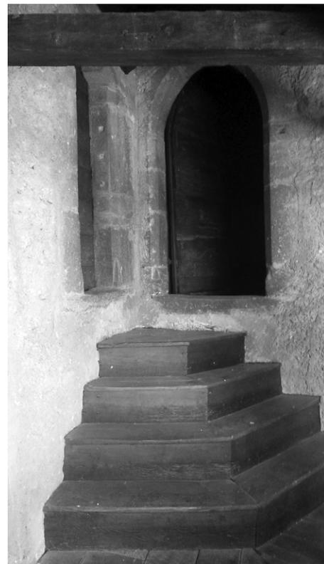
*Fig. 5. Fénis, castello; ballatoio, secondo piano, angolo sud-ovest. Alcuni degli elementi utilizzati per realizzare gli stipiti della porta sulla sinistra recano tracce della primitiva esistenza di un'inferriata, segno di un loro impiego originario con funzione di finestra*
