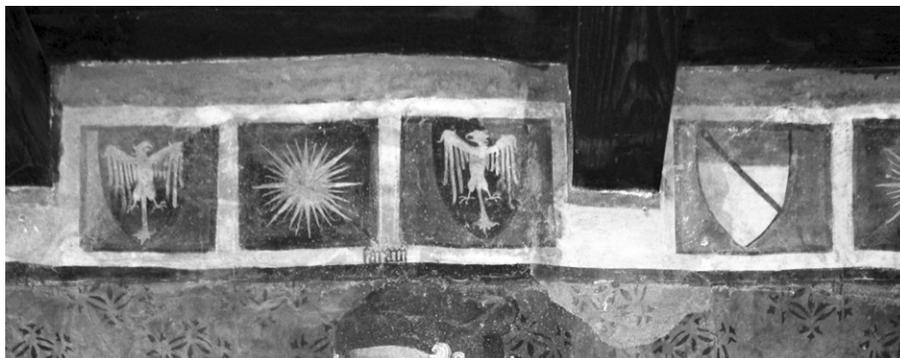
Fig. 3. Fénis, castello; ballatoio, primo piano, lato ovest. Le ridipinture del fregio che mascherano i risarcimenti di intonaco indicano una sostituzione delle originarie travi a sostegno del ballatoio del piano superiore
