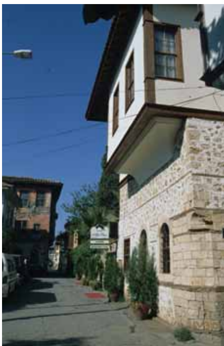
Maison réhabilitée à Antalya
