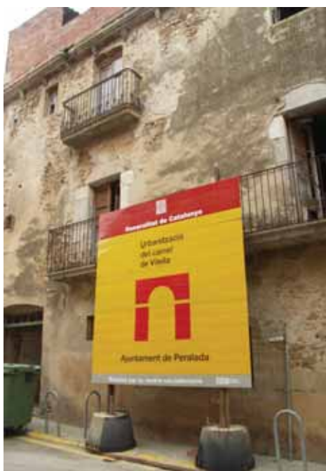
Travaux de réhabilitation à Peralada (Catalogne, Espagne)
