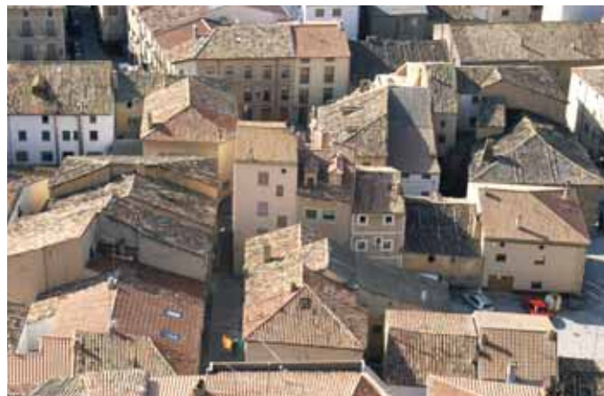
Village dans les Corbières (France)
