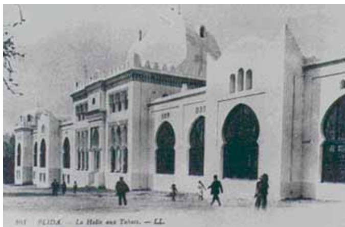
Construction coloniale avec des éléments traditionnels à Blida (Algérie)
