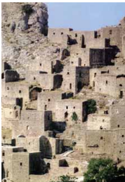
6. Village abandonné dans les montagnes grecques.
