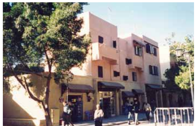
Figure 5. Deuxième projet majeur : la réhabilitation du quartier connu sous le nom de "Forum des religions" au Vieux-Caire. Sur la photo, nous voyons la réhabilitation des façades et des magasins dans le cadre du projet. (© Mahmoud ISMAIL)
