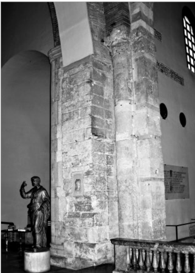
fig. 2 – Pilastri lapidei paleocristiani della crociera di San Nazaro Maggiore e loro ristrutturazione di età romanica.
