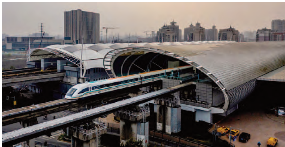
Figura 3. Il tetto della stazione di Shanghai è coperto da pannelli fotovoltaici che forniscono elettricità ai treni
