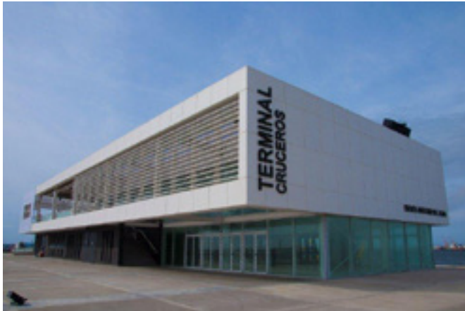
Terminal de Cruceros, Escollera Norte 15 .
