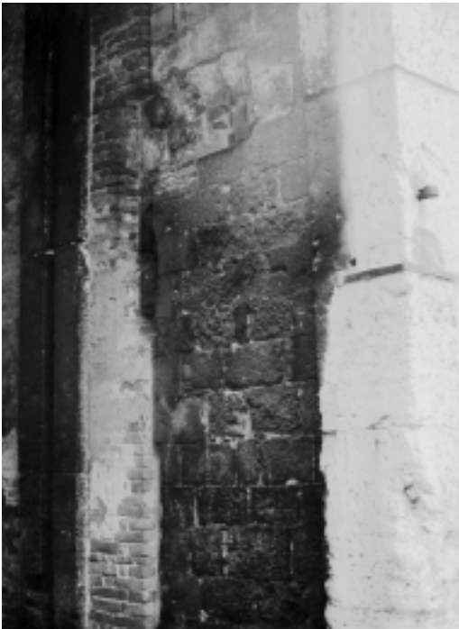
Fig. 3 - Paramento medievale del fornice di Porta Vecchia ( Porta Cittadina ), lato settentrionale.
