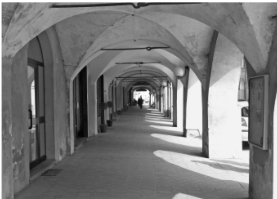
Fig. 1 - Cherasco. I portici lungo la platea , con resti di strutture tardomedievali (foto E. Lusso).
