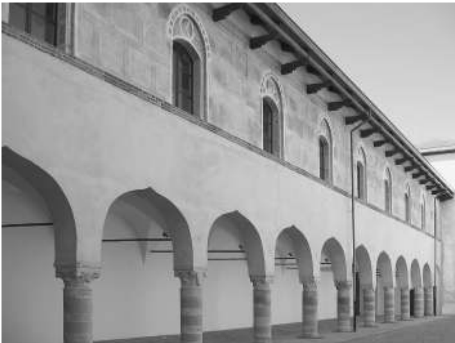
Fig. 6. Palazzo marchionale di Trino. Il portico occidentale della corte.
