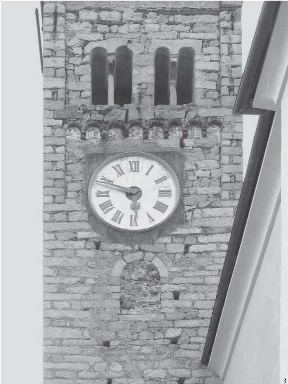
Fig. 3. Mezzana Mortigliengo. L'originario accesso sopraelevato del campanile fortificato della chiesa di San Bartolomeo.
