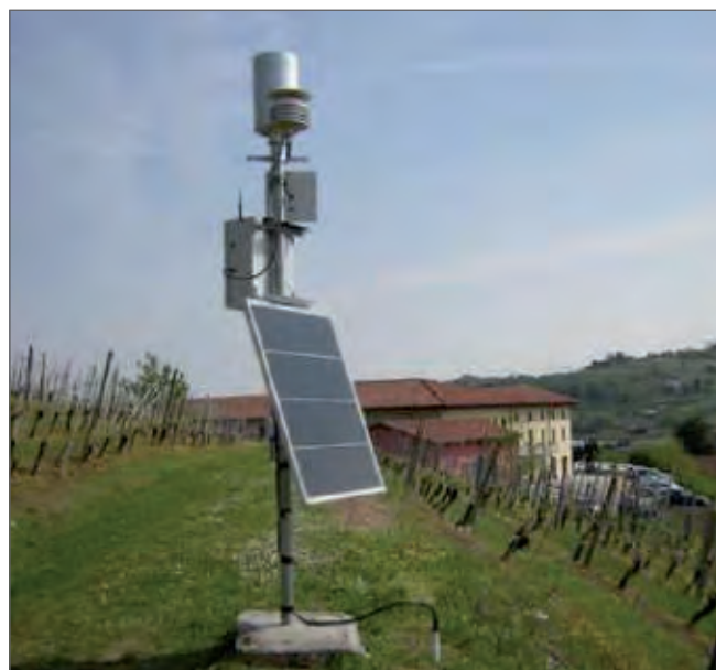
Figura 1: Stazione master installata a Alba
