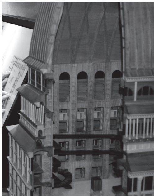
Foto 2. La struttura interna della Mole dallo spaccato del modello in legno.
