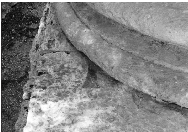
Fig. 18. Alloggiamento della grappa analizzata sull'arco di Augusto.
