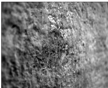
Fig. 4. Macrofotografia in cui si osservano strati di colore grigio e rosso presenti al di sopra di uno strato bianco, dall'interno del fornice.
