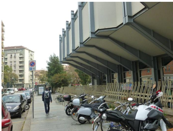
Fig. 20 - Marciapiedi di via s. Ottavio sotto le aule grandi
