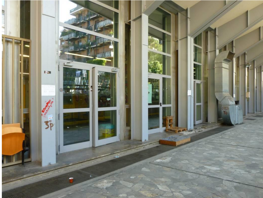
Fig. 17 - Accesso alla sala studio dal percorso interno adiacente via S. Ottavio
