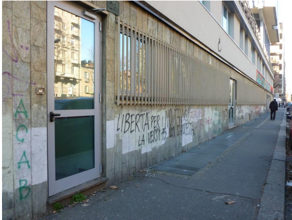
Fig. 19 - Ingresso ex alloggio del custode su corso San Maurizio
