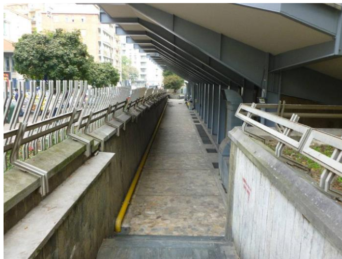
Fig. 21 - Imbocco del percorso interno lato ingresso principale del palazzo
