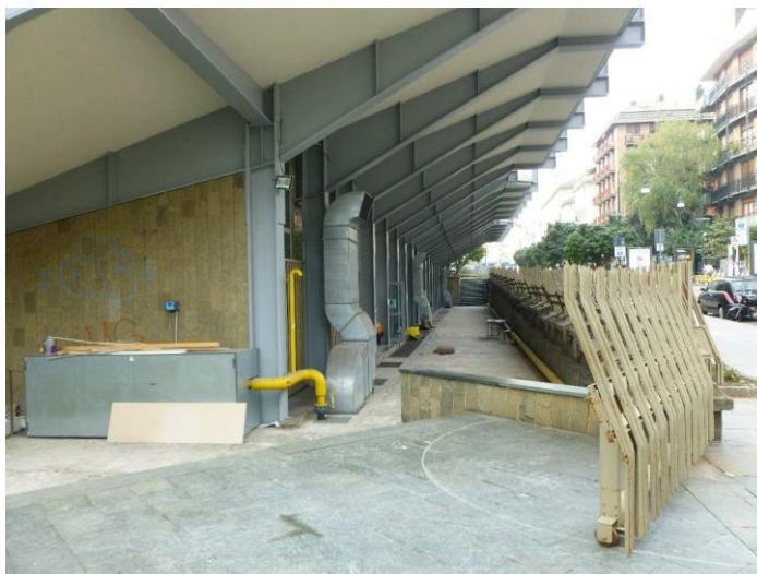
Fig. 22 - Controcampo del percorso interno
