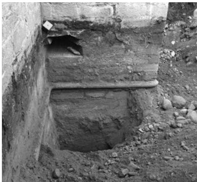
Fig. 149. Domodossola. Cinta urbana settentrionale e torre (paramento est) in corso di scavo.
