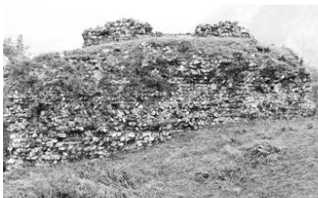
Fig. 152. Gravellona Toce. Edificio A, prospetto meridionale.
