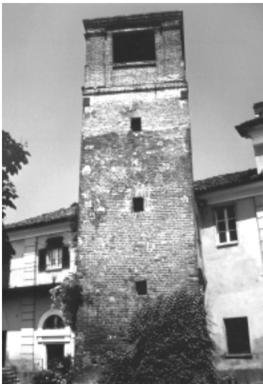
Fig. 4 - La torre a difesa di uno degli impianti molitori presso Riva di Chieri (foto E. Lusso).
