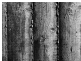
Fig. 3 Le assi di legno usate in edilizia, possono lasciare una traccia organica sulla superficie del cemento.
