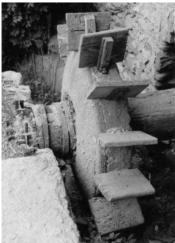
Fig. 10. Melle (val Varaita). Ruota di martinetto per metalli alimentata dal basso (foto E. Lusso, 1998).
