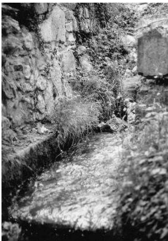
Figg. 4 e 5. Demonte. Ciò che resta della segheria comunitaria: il canale deviatore con resti poco significativi di muratura (a sinistra) e una paratoia con la bocca di scarico (foto E. Lusso, 1998).
