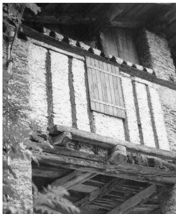
Fig. 12. Stroppo, borgata Contà. Edificio realizzato con sistema a traliccio fackwerk (foto E. Lusso, 1998).
