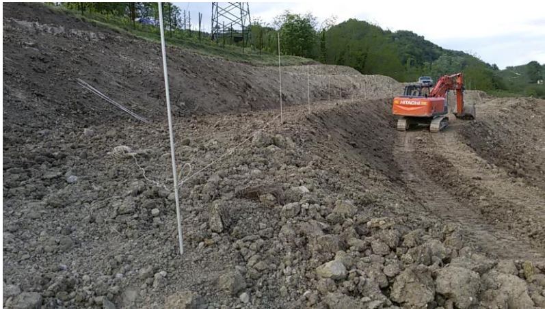
Figura 3: sagomatura ciglioni + shaping embankments
