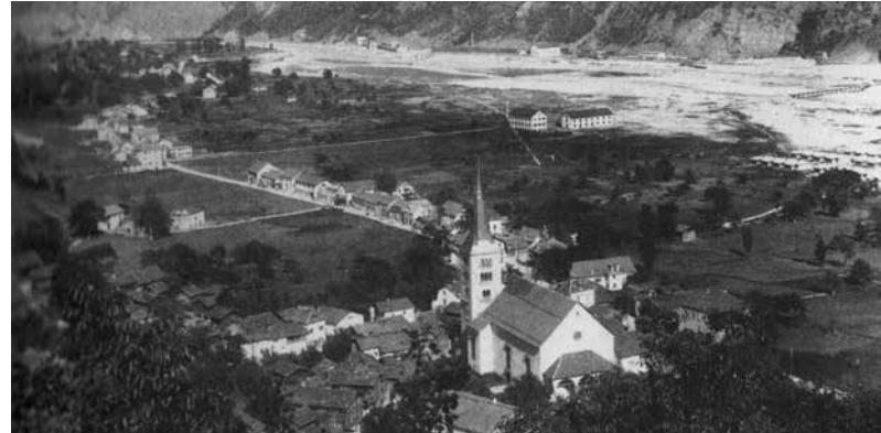
Abbildung 2a. Um 1900 zog sich ein bedeutender Teil des neuen Italienerquartiers von Naters entlang der alten Furkastrasse gegenüber der Tunnelbaustelle auf der anderen Uferseite der Rhone (Stiftung historisches Erbe der SBB Bern).
