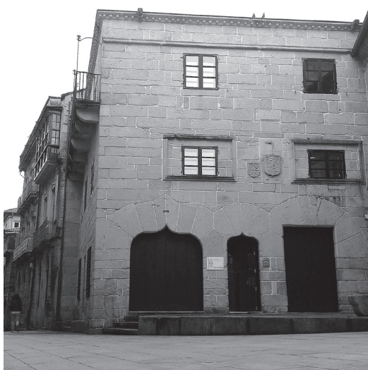
Foto 4. Centro. Casa das Campás, Sede Vicerrectorado Campus de Pontevedra
