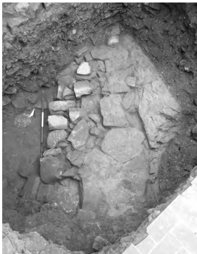
Fig. 11. Acqui Terme, piazza della Bollente. Palazzo Scati. Strutture us 5 e us 6 (foto Lo Studio s.r.l.).
