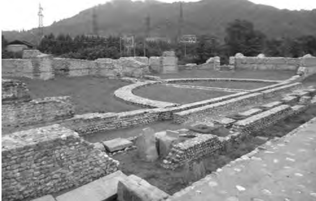
Fig. 33. Serravalle Scrivia. Area archeologica di Libarna . L'intervento di restauro sul teatro a fine lavori.
