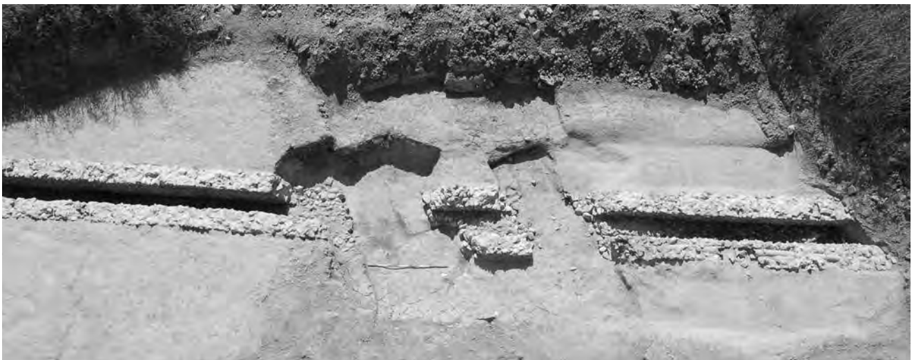
Fig. 18. Arquata Scrivia, lato ovest strada Campora. Tratto dell'acquedotto romano di Libarna con in basso a destra la fistula in terracotta lungo la spalletta est (foto Lo Studio s.r.l.).
