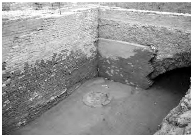
Fig. 15. Alessandria. Ponte della Cittadella. Saggio 1. Le strutture us 125 (a sinistra), cui si sovrappone il timpano del ponte tardottocentesco, e us 124 (a destra), quest'ultima sovrastata da uno dei perimetrali della casa cantoniera (foto Arkaia s.r.l.).
