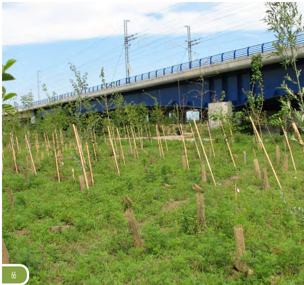
Intervento di ripristino di area di cantiere alta velocità Torino - Milano
