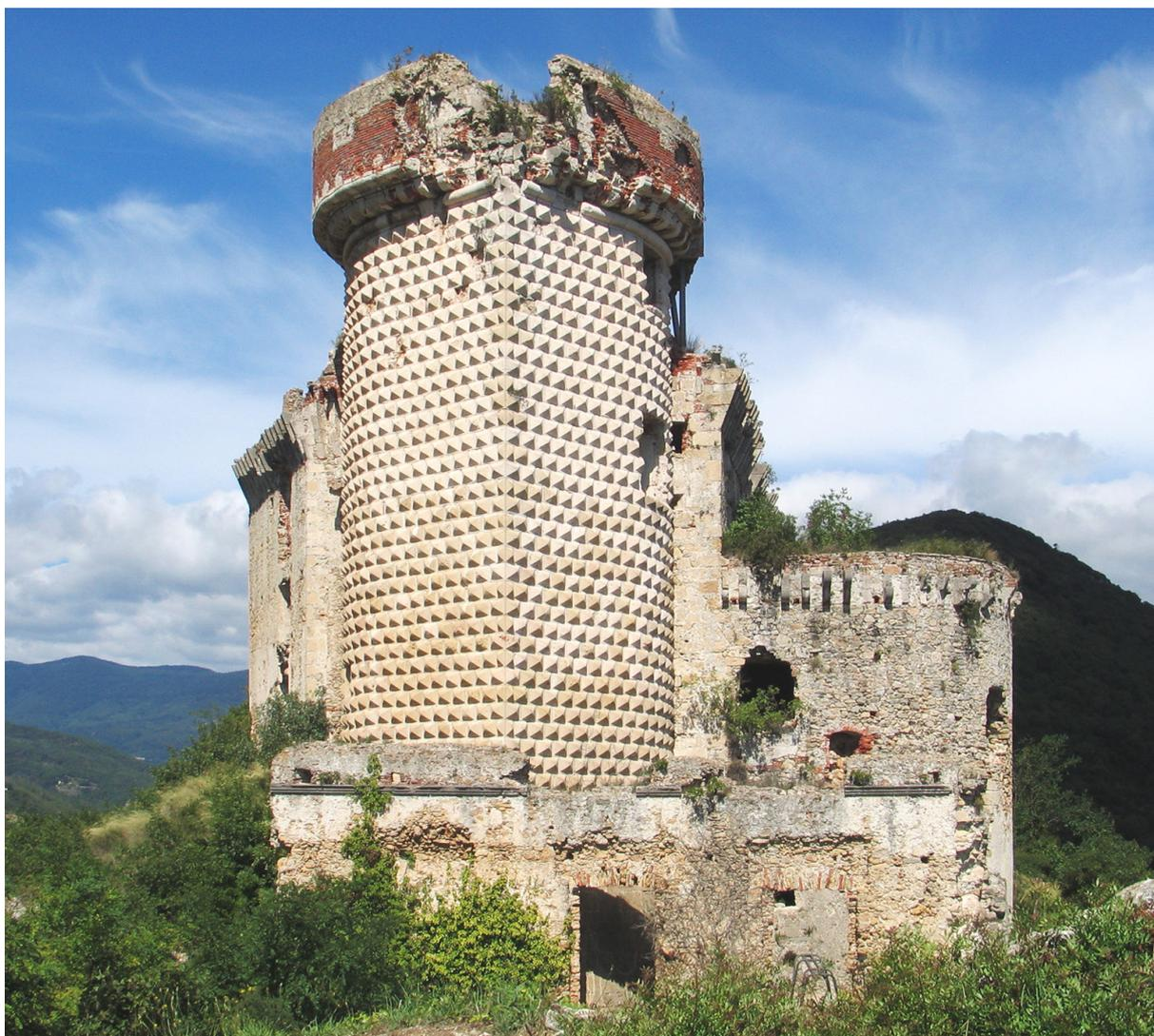
Fig. 21. La torre con profilo a goccia e paramento murario in bugnato a punta di diamante di castel Govone (foto E. Lusso)
