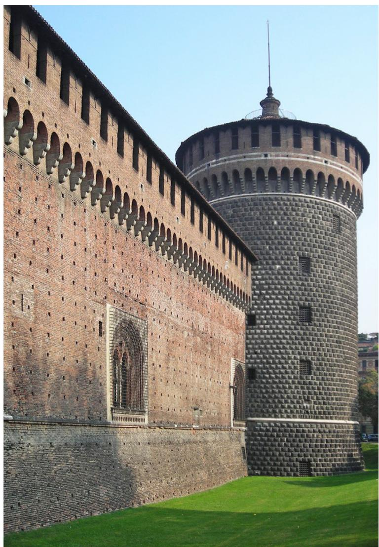
Fig. 24. Una delle torri con paramento murario in bugnato a punta di diamante del castello di porta Giovia a Milano (foto M. Cavini)
