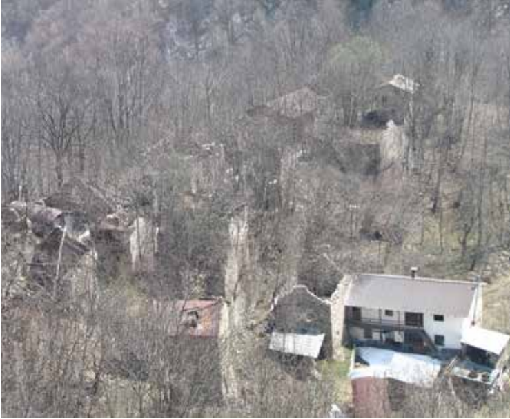
FIGURA 3: L'aspetto ruderizzato del nucleo di Saret della Borgata Bergemolo, con in primo piano le uniche unità residenziali recuperate, in contrasto con l'esteso avanzare del bosco tra le altre. Fotografia D.G., 2013.
