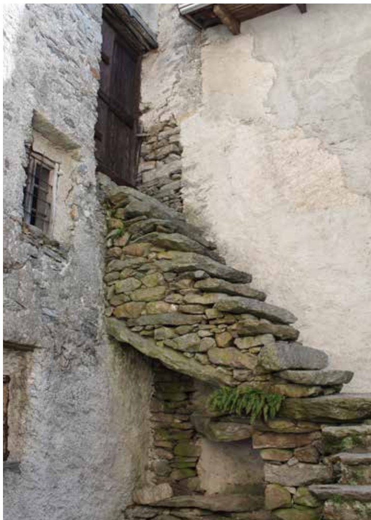
FIGURA 2: Piedicavallo (BI), frazione Montesinaro. Esempio di scala esterna in pietra realizzata a secco, inserito nella guida al recupero dell'architettura tradizionale del G.A.L. Montagne Biellesi. Nelle guide si propone una classificazione degli elementi costruttivi tipici descrivendoli attraverso schede con documentazione fotografica.
