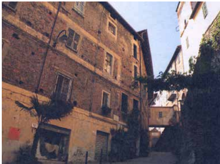
FIGURA 3: Ivrea, veduta degli edifici che seguono l'andamento dell'antica cavea del teatro lungo via Peana.
