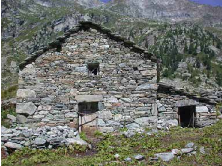
FIGURA 5: Caratteristica struttura di ricovero in contesto nel quale le scelte in termini di materiali sono rispondenti alle risorse locali. Foto Scuola, 2003.
