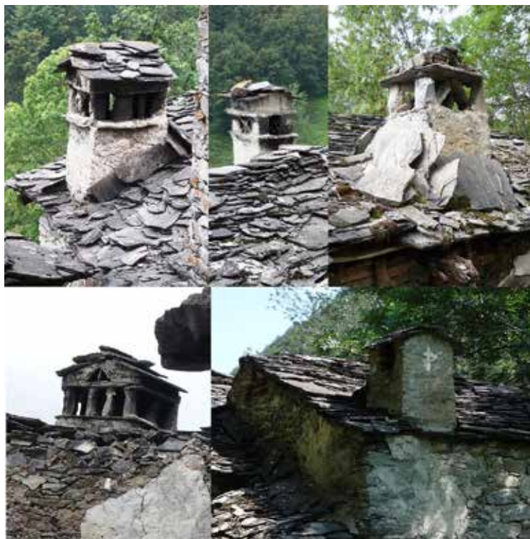
FIGURA 4: Particolari costruttivi: i camini. Foto L. Viola 2013
