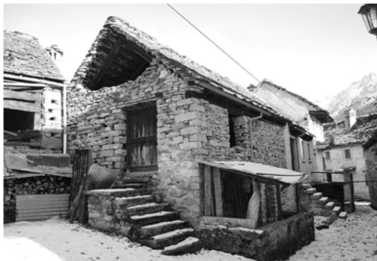
FIGURA 6: L'uso sapiente della pietra a spacco nel contesto rurale alpino. Borgata Cravegna di Crodo, Valle Antigorio. Foto A.S., 2014.
