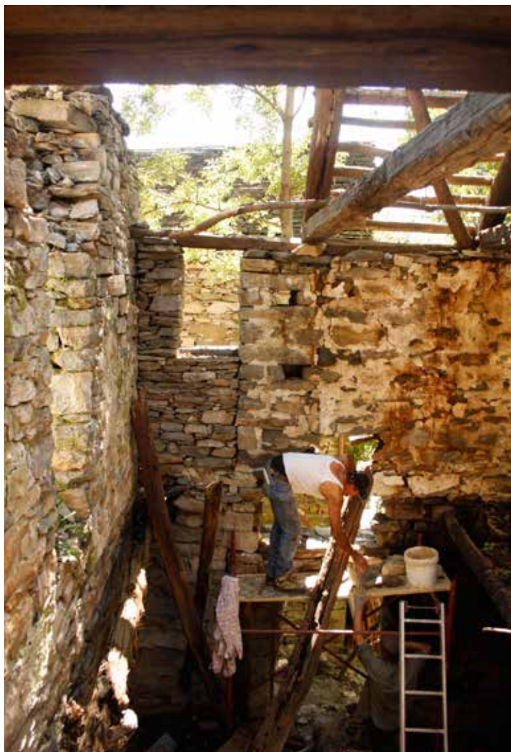
FIGURA 7bis: Lavori di sistemazione di un architrave nella casa dell'associazione a Ghesc. Foto di Maurizio Cesprini, 2011.
