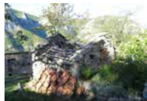
Piccolo edificio con tetto racchiuso in paglia da ricostruire (Ormea - CN)
