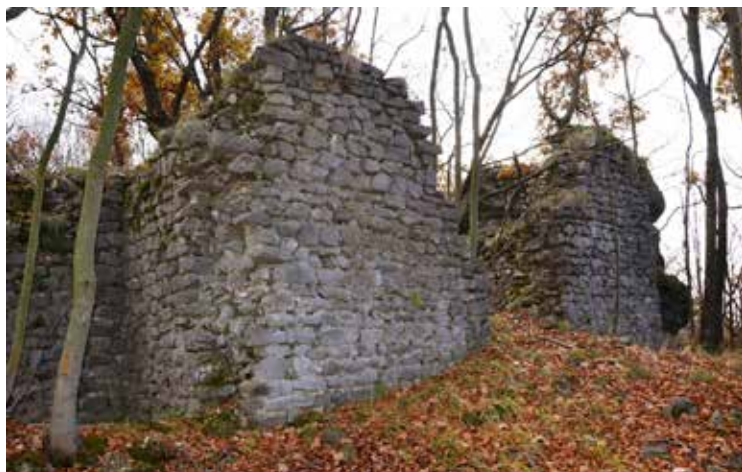
FIGURA 2: L'ingresso della torre sommitale: si noti la mancanza delle testate d'angolo, pietre lavorate con particolare attenzione e perciò le più appetibili per il riuso. Foto: Nicolò Acquadro, Simone Bombaci.
