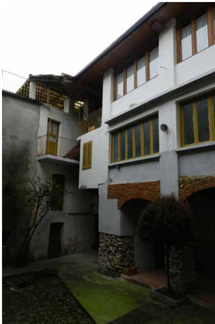
FIGURA 4: I cortili interni sono stati trasformati in base alle esigenze funzionali e abitative.
