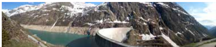
FIGURA 1: Segni vistosi di infrastrutturazione di servizio anche a quote notevoli, ormai parte integrante di una struttura storica del territorio consolidata. Veduta panoramica dell'invaso artificiale della diga di Place-Moulin in Valle d'Aosta. Foto S.M.R, 2014.
