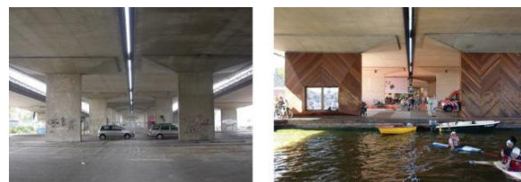
Fig 2 Space reconstruction under Koog aan de Zaan Bridge
