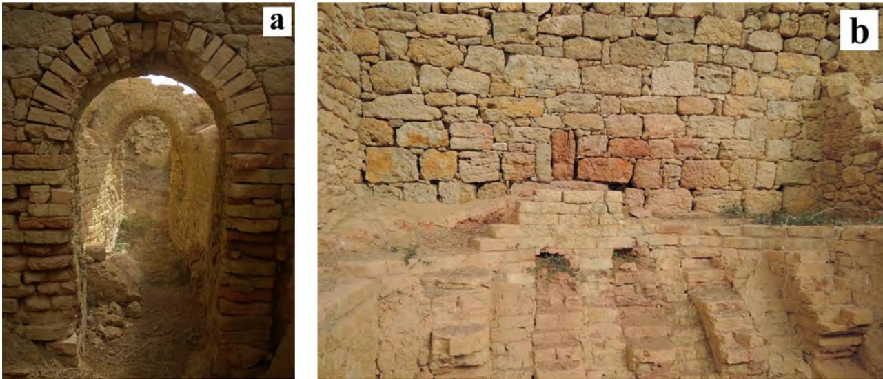
Figura 20 - Grande fornace: a) Vista da Nord verso Sud degli archi dei due prefurni contrapposti; b) Zona d'imposta degli archi a sostegno del piano di cottura della fornace, con evidenti tracce rossastre di esposizione alle alte temperature sulle pareti.
