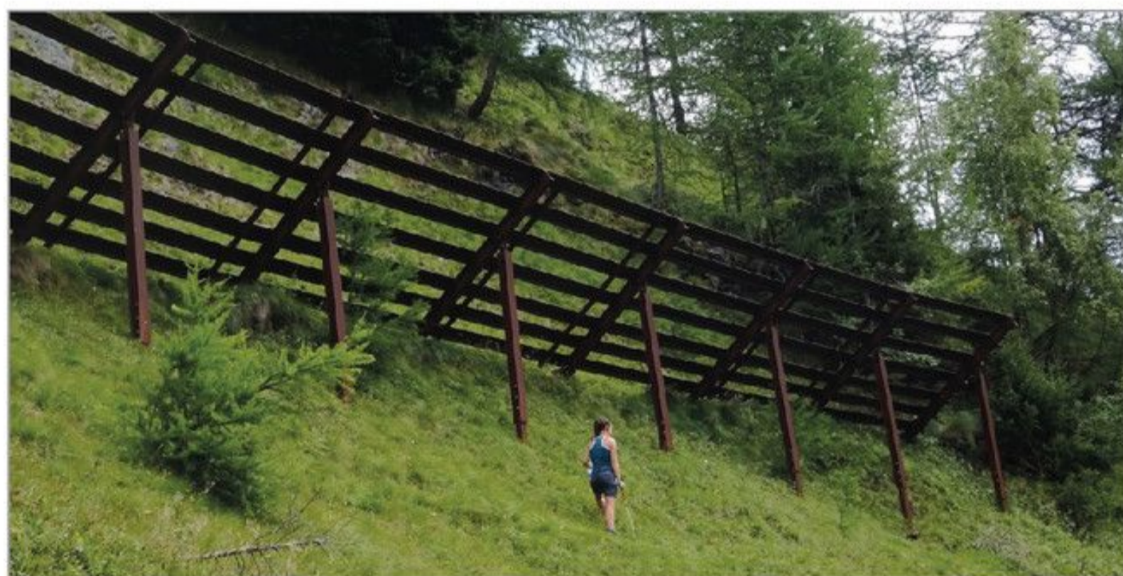
Ponti da neve in acciaio utilizzati per prevenire il distacco delle valanghe (DISAFA ® ).
