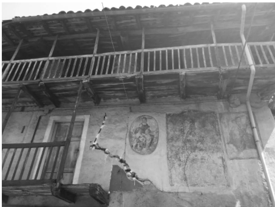
Fig. 7 - Rivara, caratteristica antica abitazione di Rivara in pietrame, con balconi e tettoie in legno (fotografia dell'Autrice).
