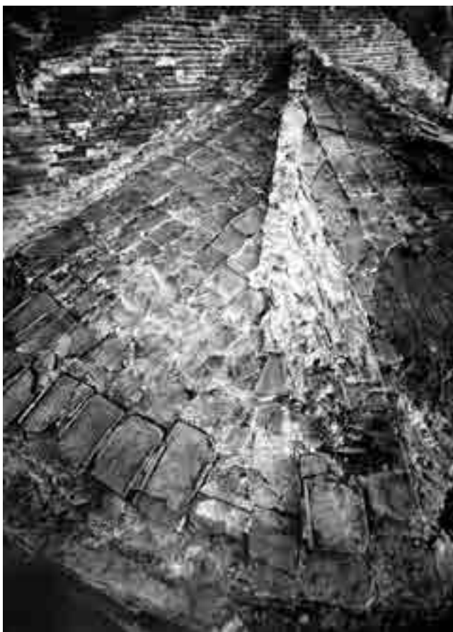
Fig. 7. Milano, Basilica di San Smpliciano, resti delle tegole e di intonaco romanici sopra la calotta absidale durante i restauri del maggio 1963, SABAPMi, Chiesa di S. Smpliciano, cass. 18, lavori 2.
