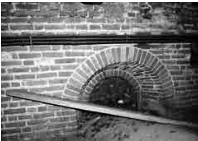
Fig. 11. Milano, Basilica di San Smpliciano, sottotetto, muro trasversale che divide la navata maggiore dalla campata a crociera costolonata prima del tiburio.
