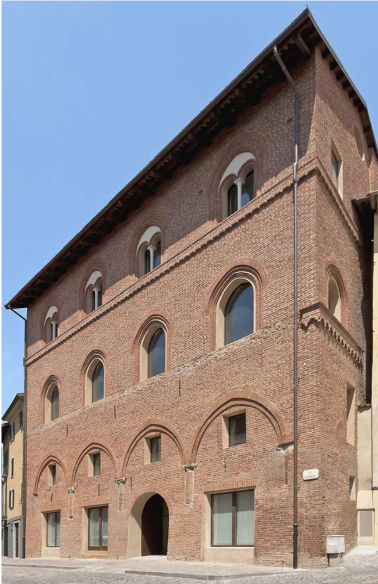
8.4 Palazzo Valfré già dei Mercadillo, Chieri, ca. 1288, prospetto principale. (foto E. Buonfrate)
