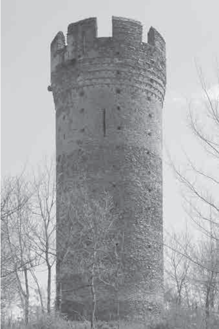
Fig. 9 - La cosiddetta Torre del Colle, già presso la villanova di Molare del Ponte, 1288-1289 (foto B. Vinardi).
