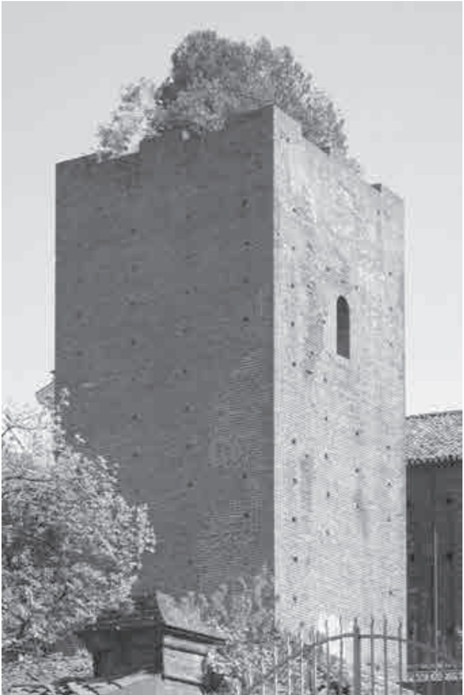
Fig. 6 - La torre della villanova di Pecetto Torinese, 1224-1227 (foto E. Lusso).
