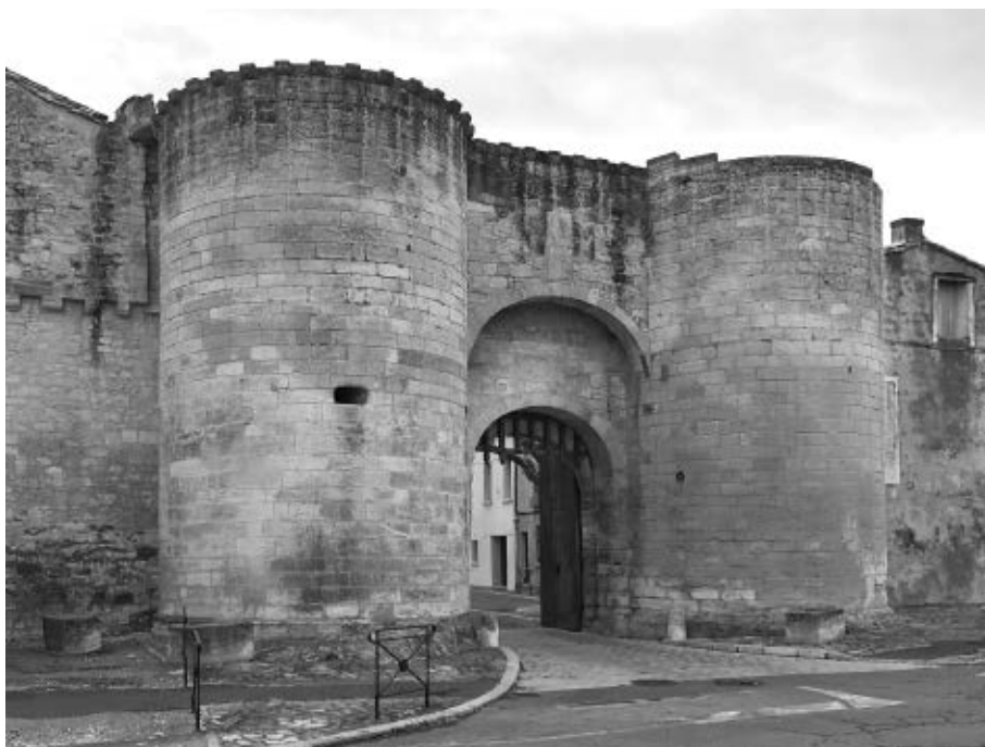
Fig. 8 - Tarascon. La porte de la Condamine delle mura trecentesche (foto E. Lusso).
