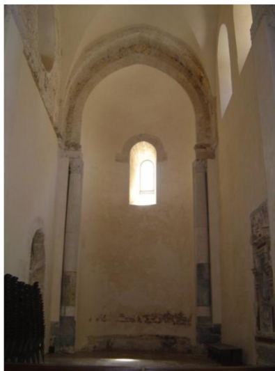
Fig. 3 – Cattedrale di Cefalù, lo spazio del Diaconicon dopo il recente restauro (nell'emiciclo dell'abside si intravedono i resti di una decorazione pittorica tre-quattrocentesca con teoria di santi).
